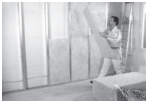
Applicazione del materiale isolante
