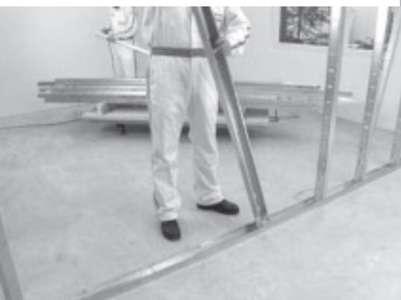
c. Montaggio dei montanti a "C"
