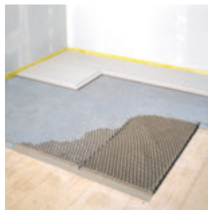
FERMACELL Sistema-sottofondo isolante per solai in legno
