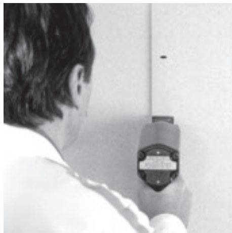
Graffe a punte divergenti (espansione) per fissaggi "lastra su lastra"
