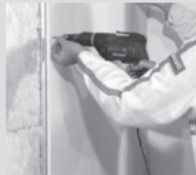
Fissaggio con avvitatore
