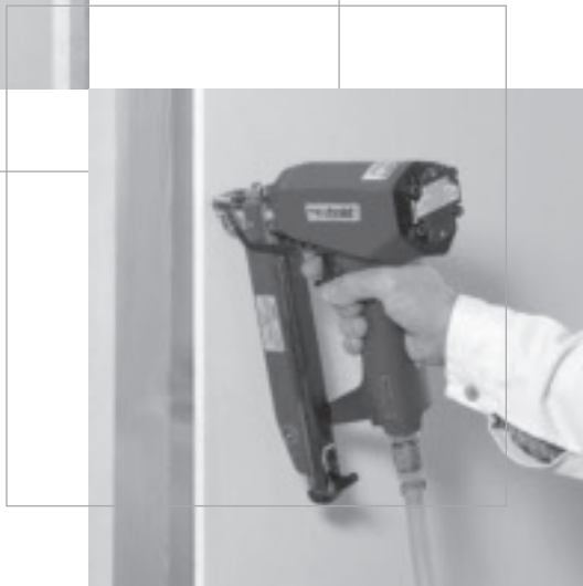
Graffe a punte divergenti (espansione) per fissaggi "lastra su lastra"
