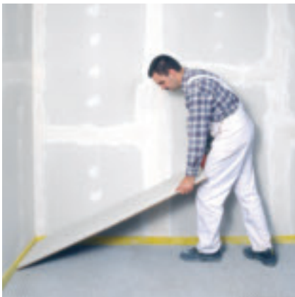
Posa delle lastre per sottofondo FERMACELL
