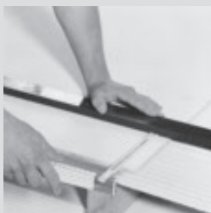
a. Misurazione della linea di taglio
