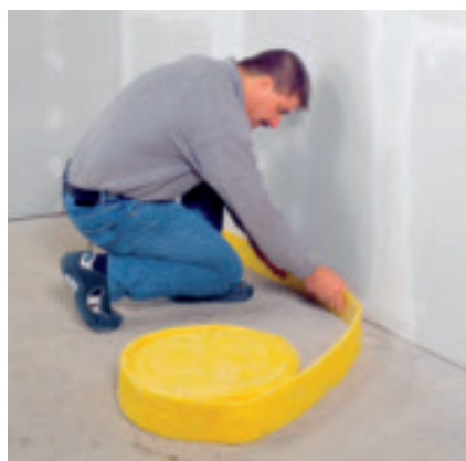
Fig. 1 – Posa delle strisce perimetrali isolanti
