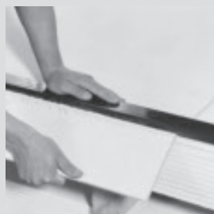
c. Rottura lungo la linea di incisione
