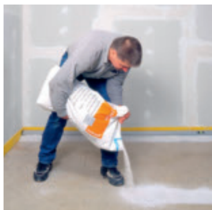
Fig. 2 – Getto delle "strisce d'appoggio" iniziali
