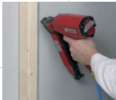
Fissare con graffe o viti alla sottostruttura
