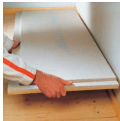
Posare le lastre per sottofondo FERMACELL
