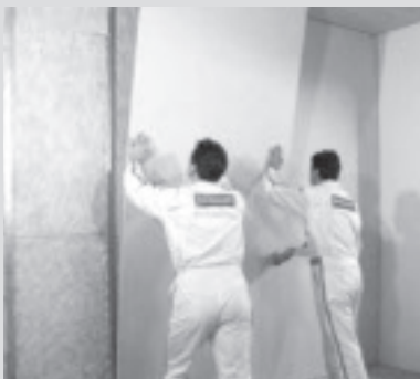
Tamponamento della sottostruttura metallica
