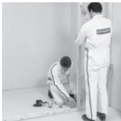
Montaggio delle sottostrutture di legno con chiodi senza testa o angolari in acciaio
