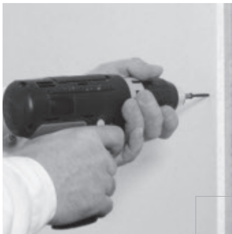
Viti su sottostruttura di metallo
