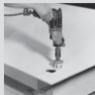
h. Fresatura fori per installazione/passaggio impianti
