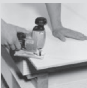
e. Taglio con seghetto elettrico alternativo
